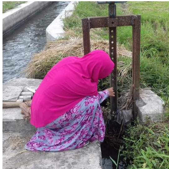
Gambar 17. Saluran Buka Tutup Tersier
